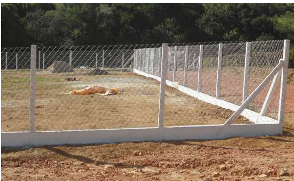
Ilustração dos detalhes das muretas e escoras
