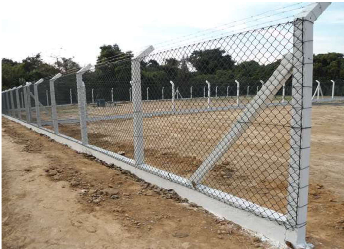
Ilustração dos detalhes dos fios, telas e amarrações
